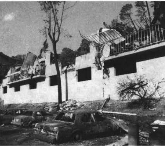
パークウッズ団地。コンクリートブロック造の車庫の上に木造3階建て共同住宅が載っていたが、車庫だけが残っている。
