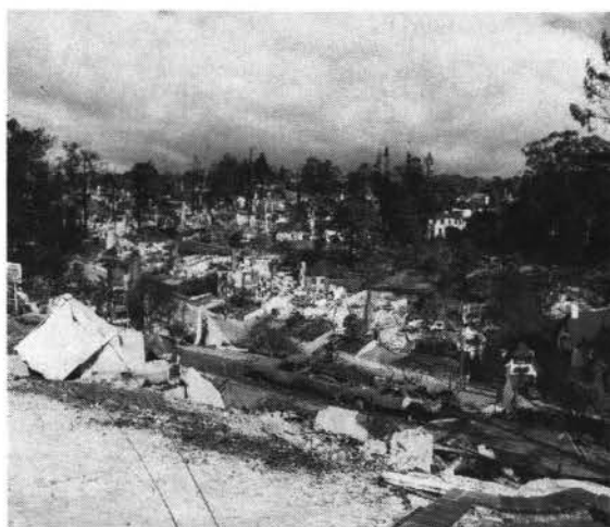
被災地区南端付近の住宅地。ここでは、林野火災というよりは、建物から建物への延焼が主だったようである。
