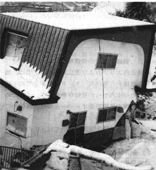
写真1 地震による家屋倒壊
