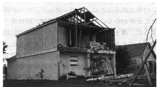
写真4 外壁の脱落
