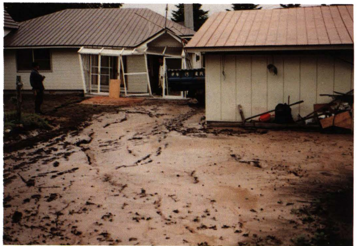
北海道駒ヶ岳南山麓地域にある森町赤井川・駒ヶ岳地区では、液状化のため家が沈んだり、噴砂現象があちこちに見られた。©森町役場
