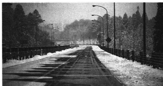
写真15 定置式の薬液散布装置
