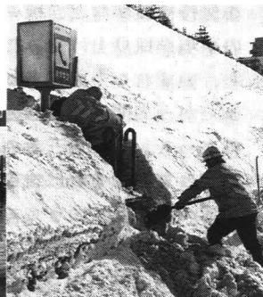
写真5 非常電話部の人力除雪
