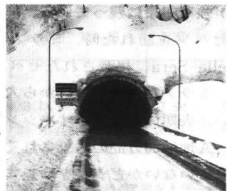
写真2 トンネル坑口のロードヒーティング
