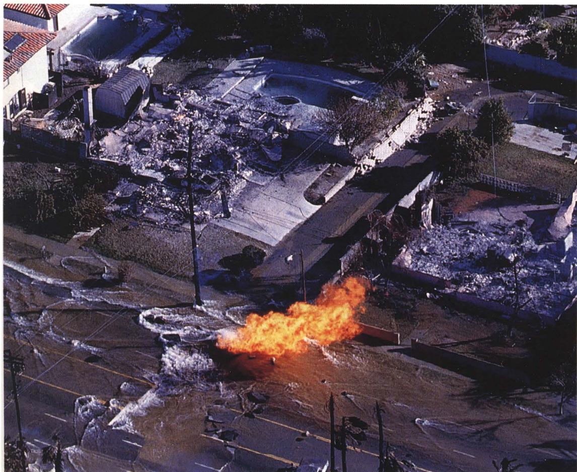
水道管とガス管が破裂し、地下から噴き出す炎と水。 （サンフェルナンドバレー）
