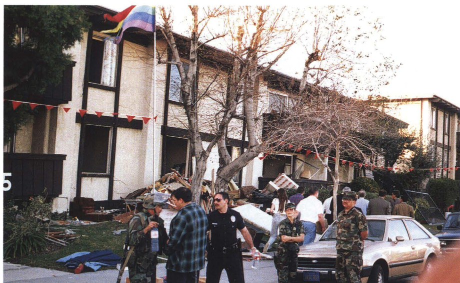
3 階建ての 1 階部分が崩壊した木造アパート（ノースリッジ）
