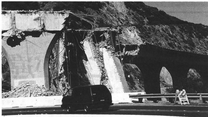
ノースリッジ地震で崩壊した高速道路
