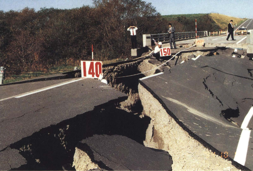
別海町の陥没した道道中春別・俵橋線の復旧工事のための計測 ここで、通りがかりの車2台が陥没した道路に突っ込み、2名 が負傷した／(社)日本損害保険協会
