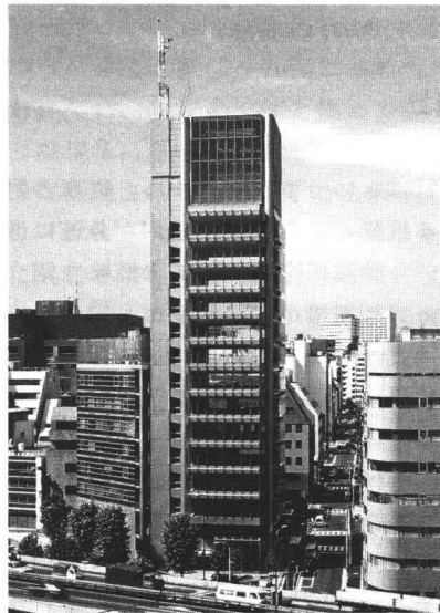
写真3 安東錦町ビル
