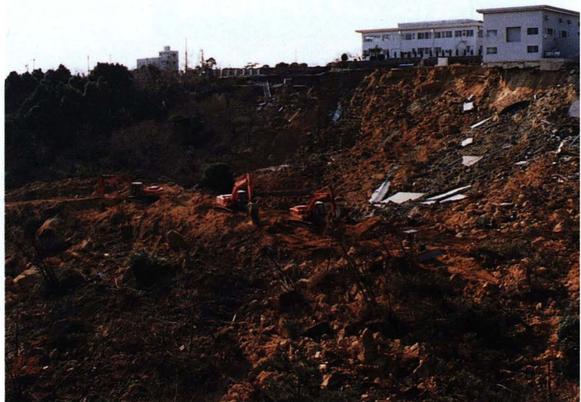
幅50m、長さ約100mにわたって土砂崩れが発生した西宮市仁川百合野町／㊟
