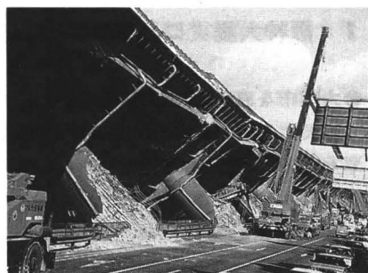
倒壊した阪神高速道路(神戸市)
