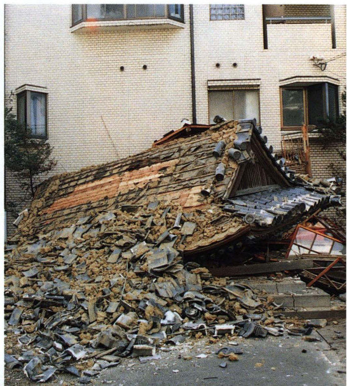
淡路島北淡町役場前の神社。今回の地震では、このように木造瓦葺き建物の被害が目立った／㊟
