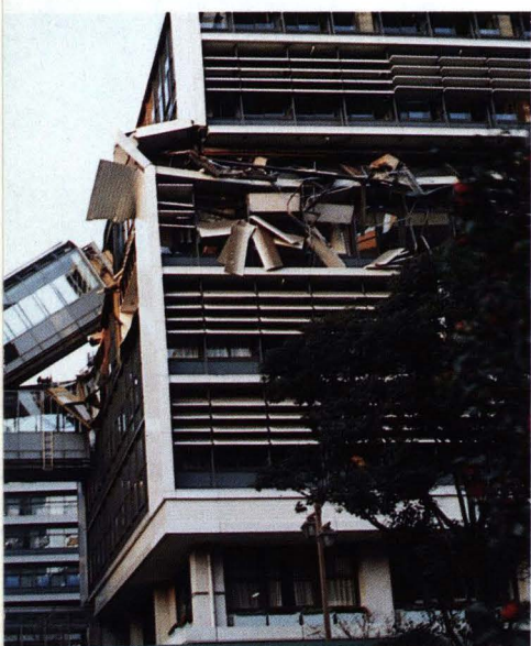
強い揺れによりわたり廊下が落ちた神戸市役所／㊟
