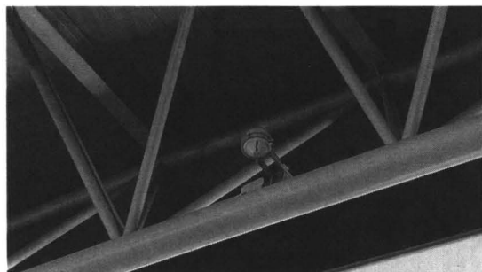
写真8 走査型火災検出器（赤外線炎検知器）
