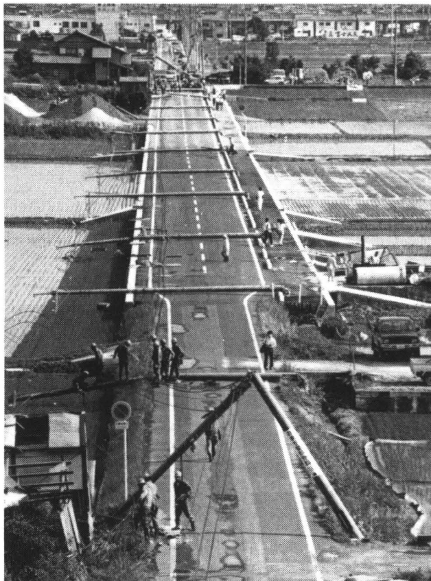
写真1 岡山市で発生したダウンバーストは51m/sの風に耐えられるコンクリート製電柱18本を倒壊させた。被害はこの付近に局在しており、現場から1 kmほど離れたとほとんどない
