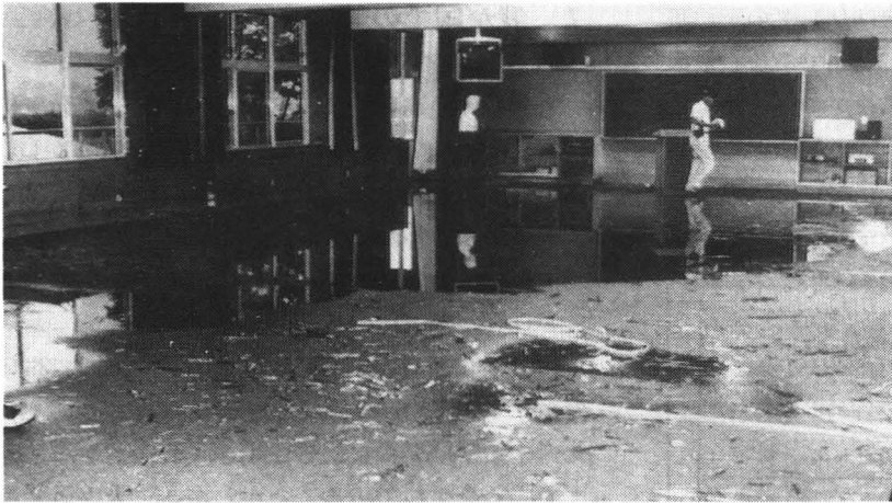
写真2 激しい突風で割れた埼玉県美里町立美里中学校の窓ガラス(1994年9月8日)。現地調査の結果、突風の原因はダウンバーストであることがわかった。
