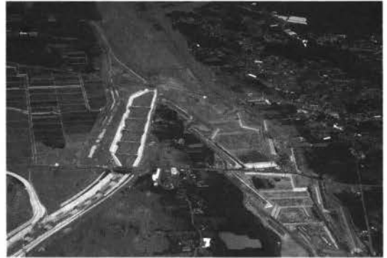
写真5 水無川下流部に建設された導流堤/建設省砂防部提供
