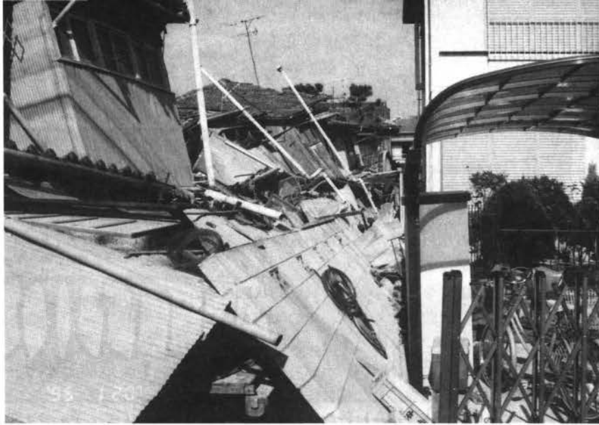
倒壊した建物(左)と被害の少なかった建物(右)
