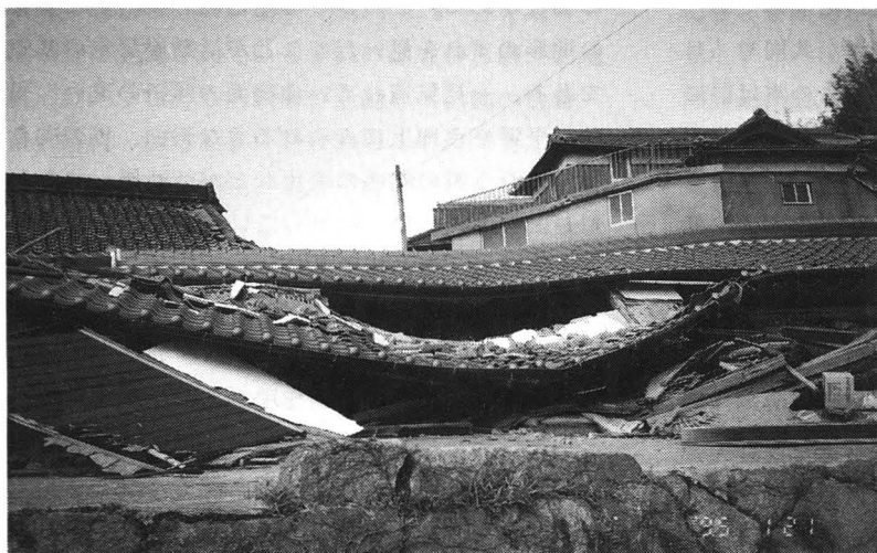
写真4 野島断層上で崩壊した家屋
