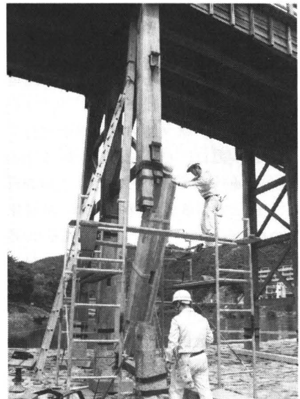
写真-2 錦帯橋の橋脚の修理(1993年7月撮影)
