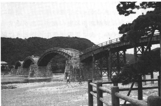
写真-1 岩国の錦帯橋(撮影者に特記ないものは筆者撮影)
