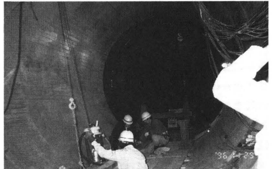
写真4 連絡管渠（奥に貯水池がある）
