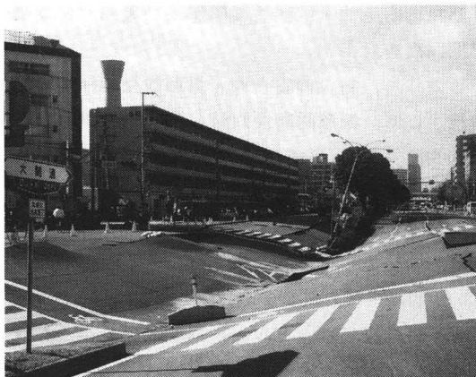
写真-3 阪神・淡路大震災の被害(地上)
