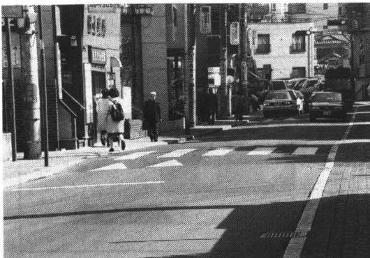
ハンプ（横断歩道の段差をなくしている）
