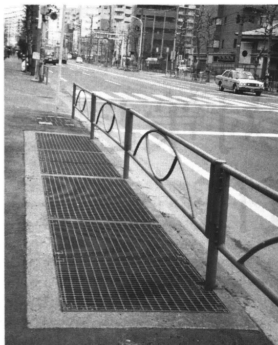
写真-6 歩道上の通風口
