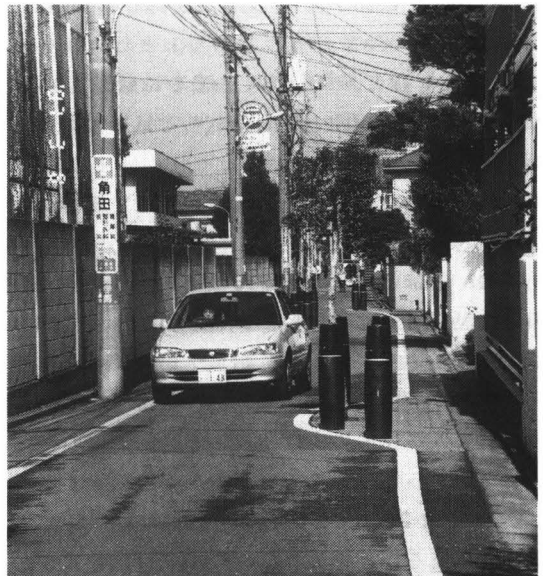
ボラード、植樹と路面表示によるシケイン
