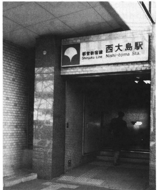
写真-7 防水扉が設置された出入り口
