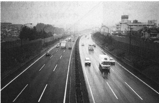
写真2 高機能舗装と(左)従来の舗装(右)
