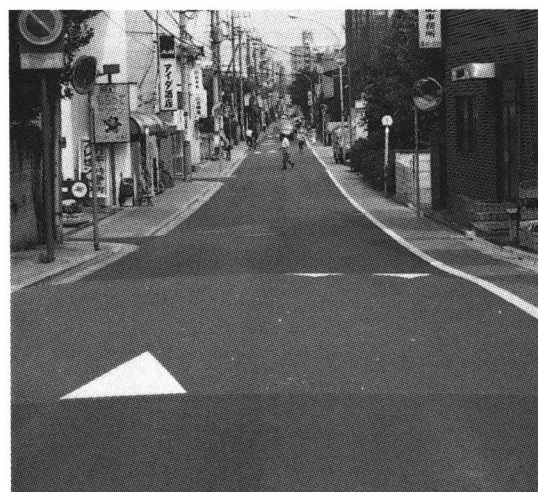
写真7 ハンプの設置状況
