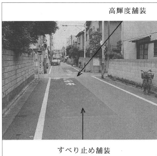
写真2 裏通り交差点での対策(舗装)
