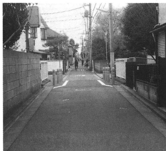
写真8 狭さくの設置状況
