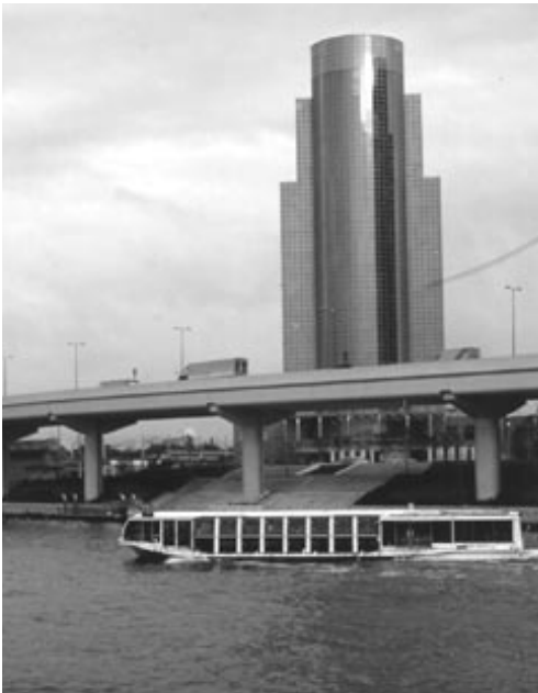
写真6 区の13番目の雨水利用施設、墨田区役所
