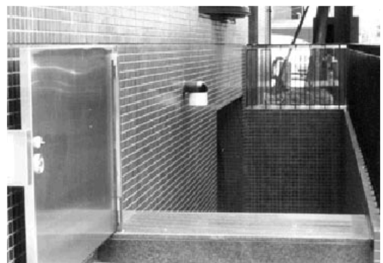
写真2 地下浸水で死亡事故を出した福岡市内のビル 「事故以降、地下室へ降りる階段の入り口は高上げされ、浸水防止扉がつけられた。」
