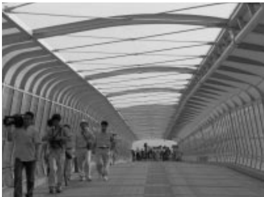
写真2 事故翌日午後6時頃（歩道橋北側から）
