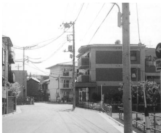
写真4 8m道路拡幅本整備完了
