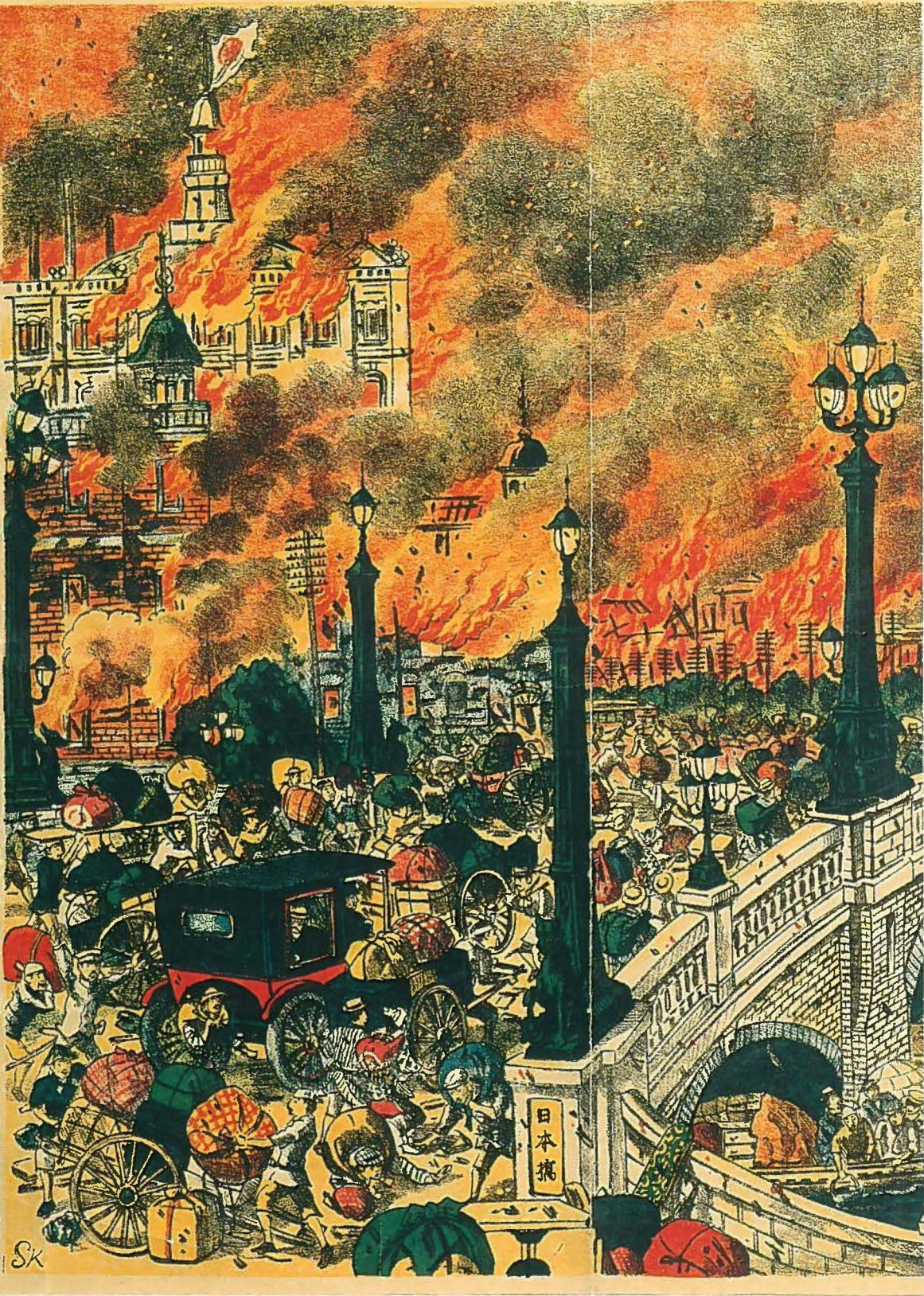
「日本橋より魚河岸及三越呉服店附近延焼」東京消防庁消防博物館蔵
