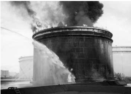
図6 30006原油タンクのリング火災 (苫小牧市消防本部提供)
