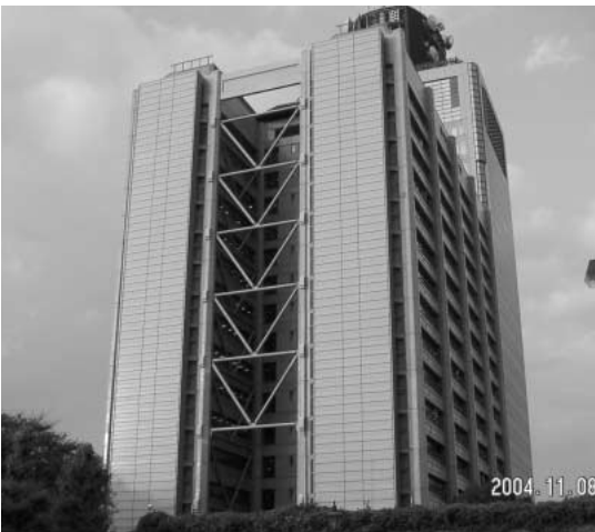
写真4 静岡県庁東館の耐震補強
