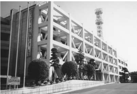
写真5 災害対策の支部となる静岡県中遠総合庁舎の耐震補強
