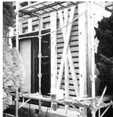
写真2 基礎と外壁の増設による耐震補強例
