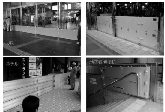
写真1 博多駅での止水版設置例
