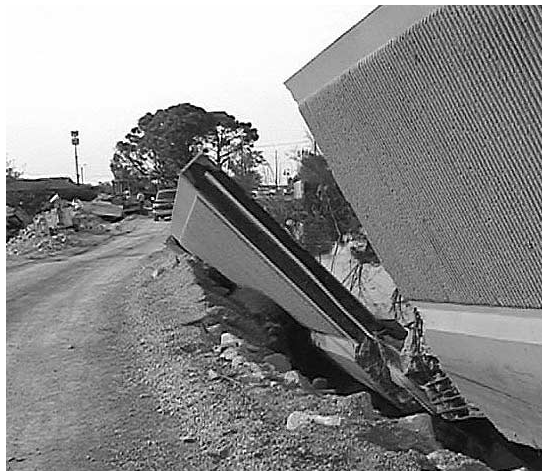
写真2 崩壊した堤防 - 2
