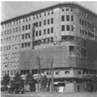
修復工事中の旧丸ビル
