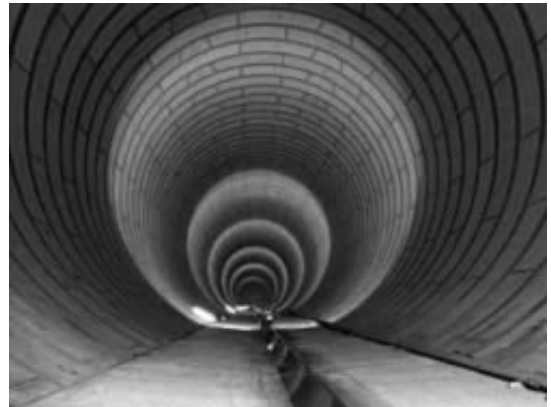
写真1 「環七地下貯水池」(東京都建設局の資料から)
