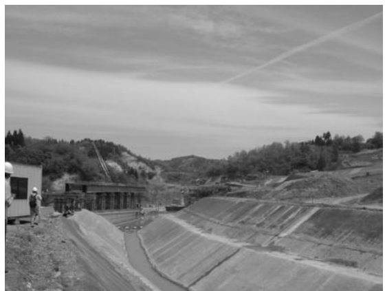
写真 6 山古志村東竹沢における水路建設状況
