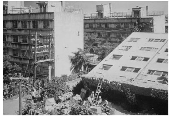
写真3 新潟地震により液状化で沈下・傾斜したアパート（渡辺隆博士撮影）
