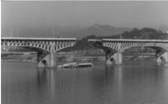
図4 ソウルでの聖水大橋の吊材の疲労による事故
