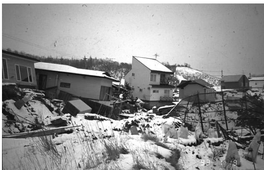
写真2 釧路沖地震で被災した造成盛土宅地
