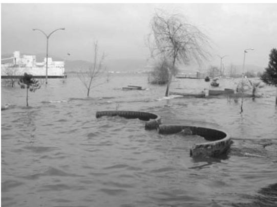
写真5 トルコ・コジャエリ地震により沈降した海岸
