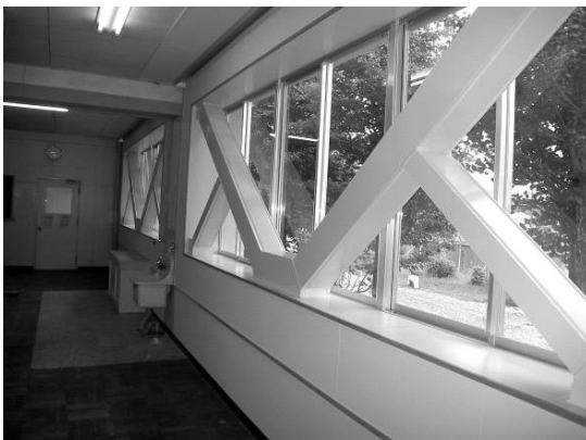
写真7 高等学校における耐震補強の実例
