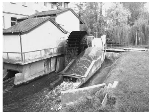
写真2 個人所有の下掛けとらせん水車発電施設
