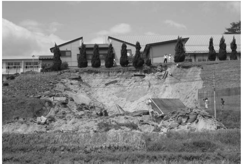
写真1 岩手・宮城内陸地震の被害
