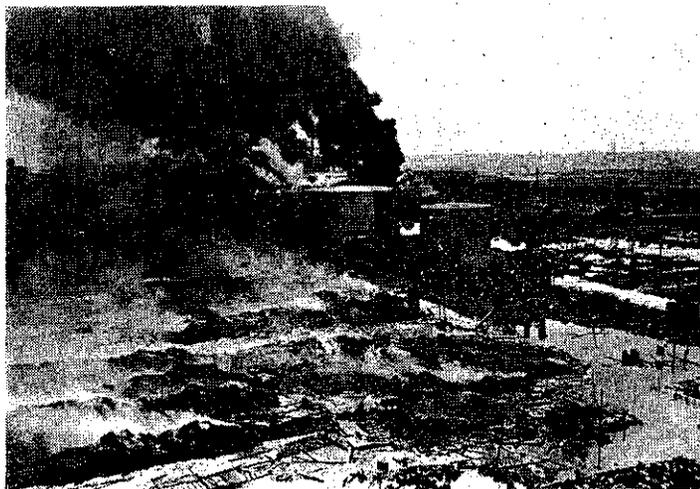
(8) バイプラインのバルブやタンクの下部マンホール(掃除口で常時は鉄蓋をボルトで締めつけてある)は長時間周囲が燃えると、パッキンや締付けボルトが狂い、漏油するようになり、これがまた燃え続ける。
